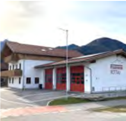
neues Feuerwehrhaus in Rottau
