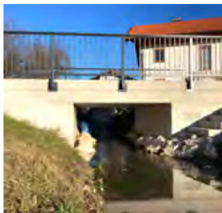
Brückensanierung in Grafing
